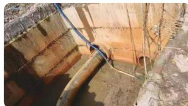
天然气利用四期工程珊瑚田线高压工程与中压管线工程共同穿越铁路。
