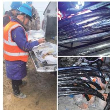
重庆香树岭风电场风机箱变低压侧电缆击穿抢修。
